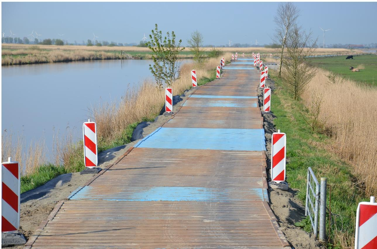
Abbildung 11: Provisorische Zuwegung als Plattenzufahrt bei einer Freileitungsbaustelle
