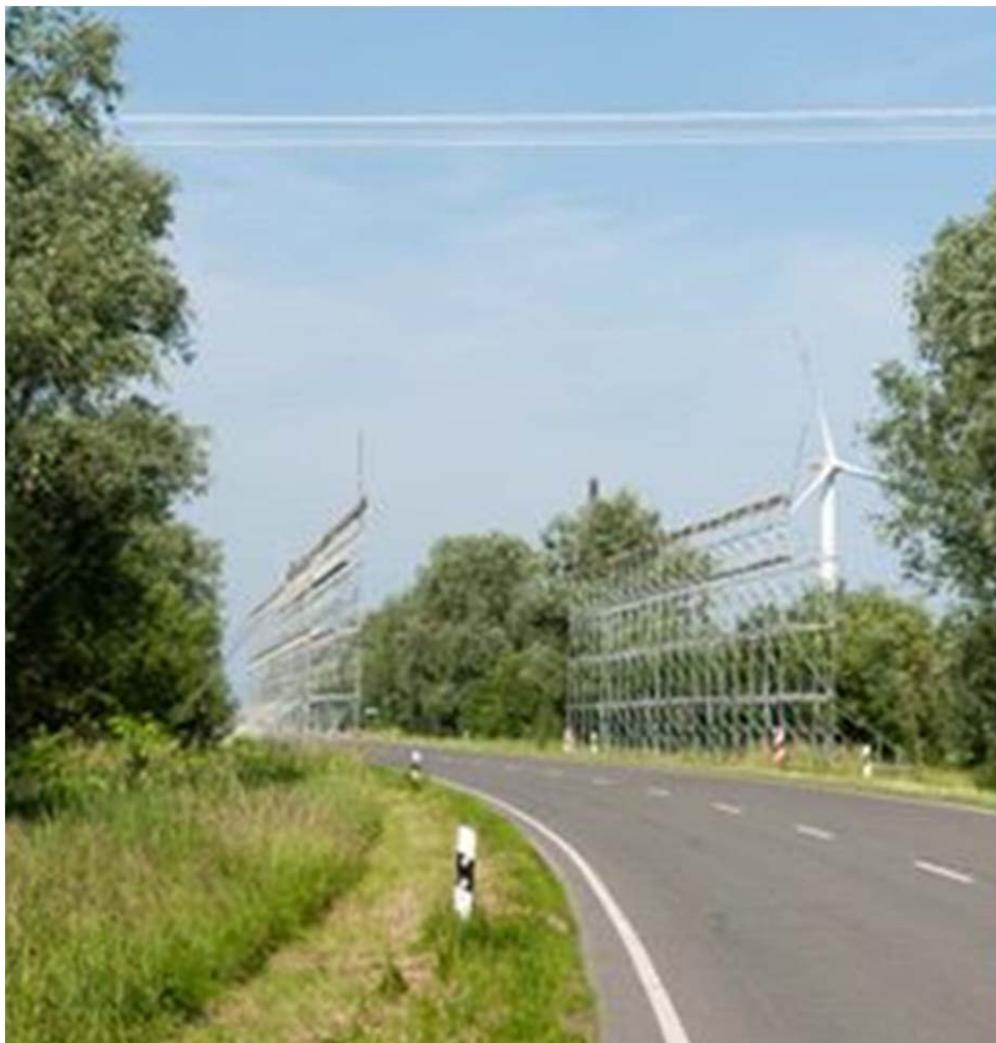
Abbildung 16: Beispiele für Schutzgerüste aus Stahl
