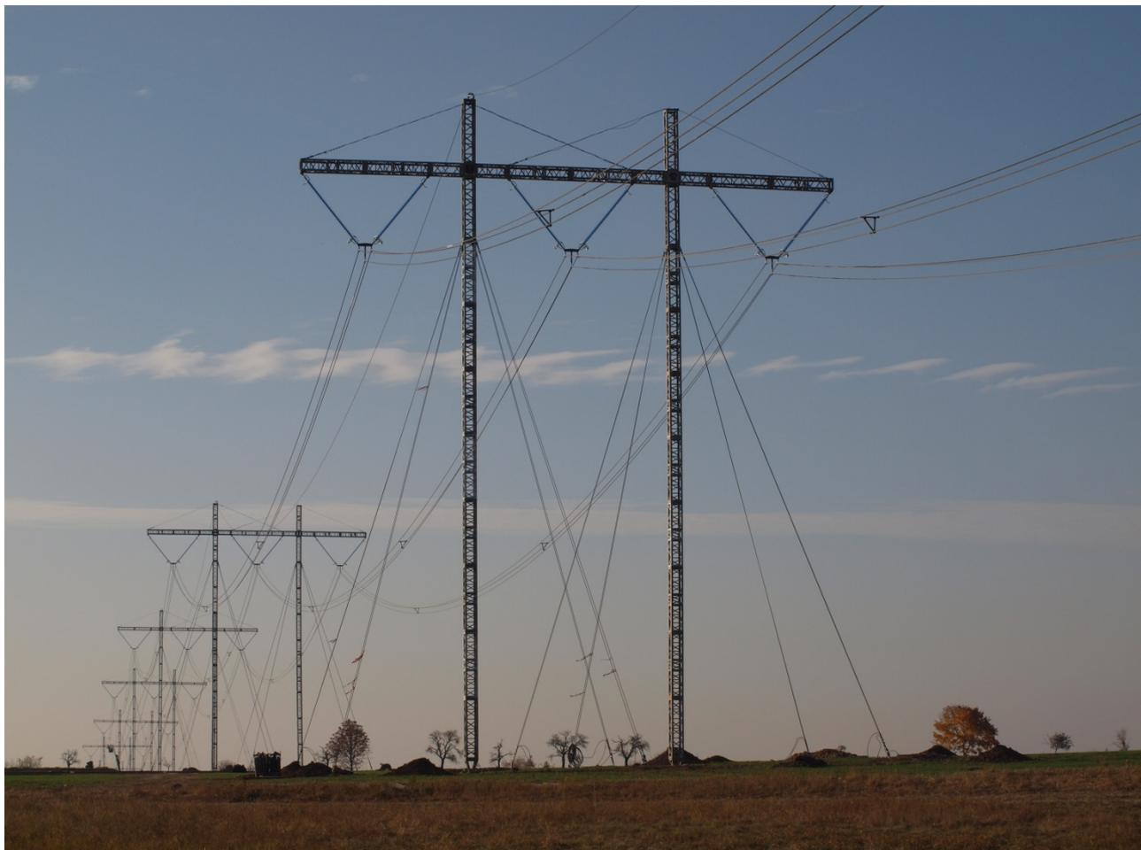
Abbildung 15: Beispiel für ein 380-kV-Freileitungsprovisorium (Quelle: SAG)
