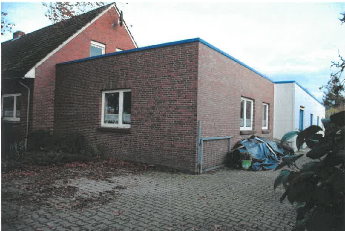
In diesem Gebäude (Teilansicht von der Bundesstraße 436) soll unser Zimmertheater entstehen.
