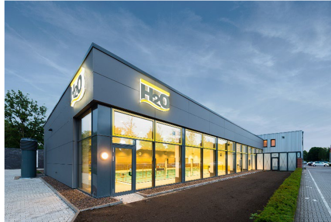
Hallenbad Dinklage Sanierung (2018) Baukosten 3,0 Mio. €
