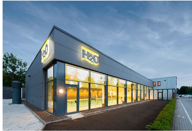
Hallenbad Dinklage Sanierung (2018) Baukosten 3,0 Mio. €
