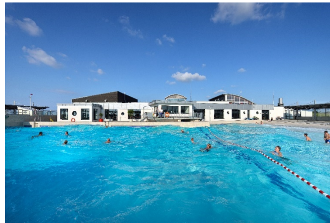
KB Dorum (Watt'n Bad) Neubau & Attraktivierung (2014) Baukosten 9,8 Mio. €
