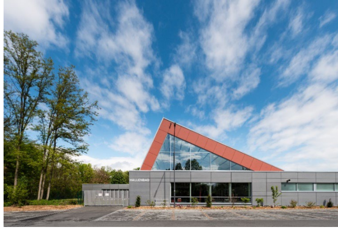
Hallenbad Delbrück Sanierung (2015) Baukosten 6,5 Mio. €
